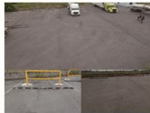
ニュートラック配合のアスファルト (健全な舗装状態)
